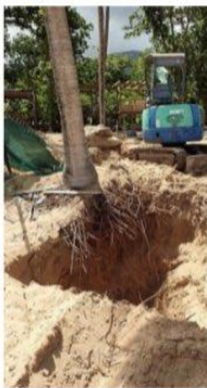
Mise en place d'enrochements sur la plage © OFB 971
